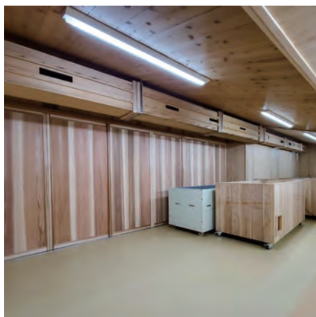
老舗酒蔵の改装工事に合わせ引戸を納品発酵飲料を扱う場所だけあって建具や内装も自然素材が良いそうです(納得!)
