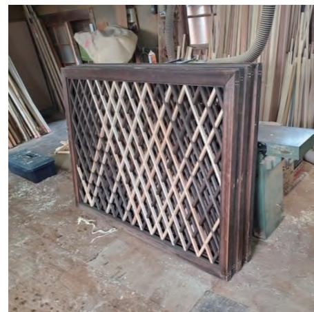
京都にある神社の塀を補修しました。傷んだ部分だけを交換。こうして文化財は次世代に受け継がれていくんですね。
