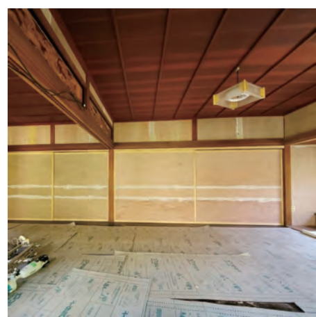
横 1.8m × 縦 1.8m の過去最大サイズ! 画像は表面にクロスを貼る前の状態です V レールのお陰で実際は軽く動きます。
