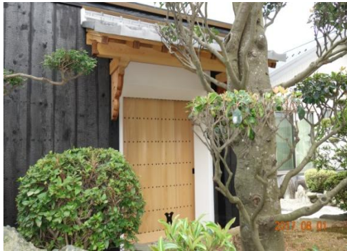
蔵の戸を納めました。すべて桧です。 カギの取り付けは苦労しました。
