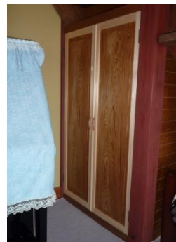
段下の両開きの押入れです。杉板でいい柵がで階ています。
